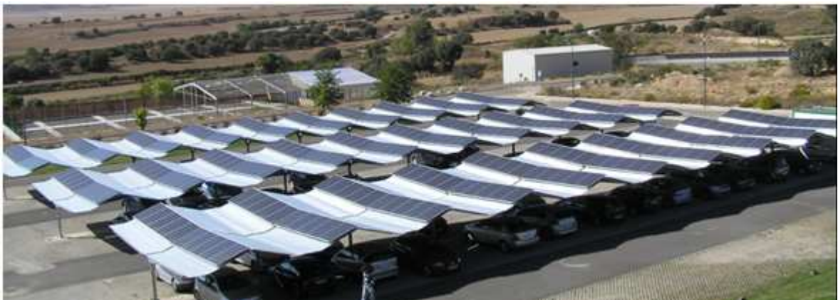
Ilustración 3. Instalación de placa fija instalada en las marquesinas del parking del Parque Tecnológico Walqa.
