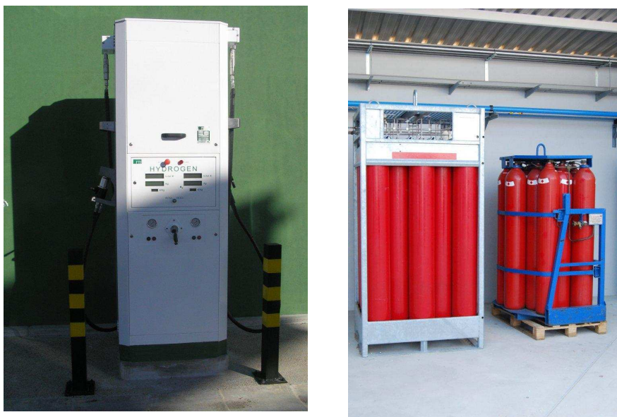
Ilustración 10. Dispensador de hidrógeno para automoción y sistema de almacenamiento de hidrógeno en forma de gas a elevadas presiones.
