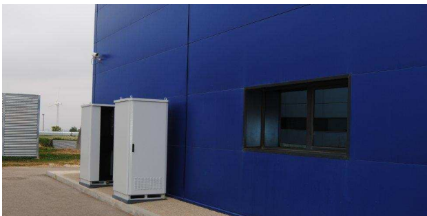
Ilustración 17. Instalación pila de combustible de 10 kW de Future, modulo especial para exteriores, se compone de 2 cuadros con stacks de 2 kW.
