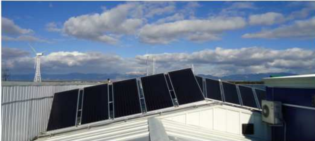
Ilustración 6. Instalación solar térmica en el edificio de Fundación Hidrógeno Aragón.
