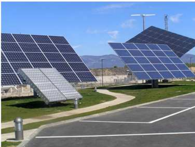
Ilustración 4. Seguidores solares en el parking de FHa.
